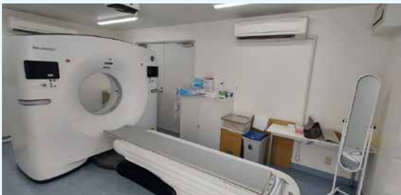
換気設備の整った CT 室内
